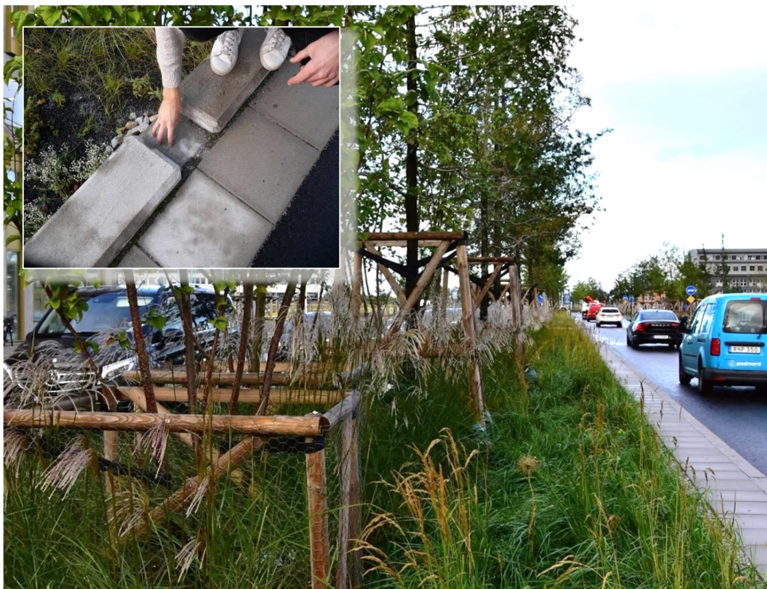
Figur 11. Exempel på växtbädd i gatumiljö, Köpenhamn. Infälld bild visar öppningar från vägytan där vatten leds in. Foto:WSP
