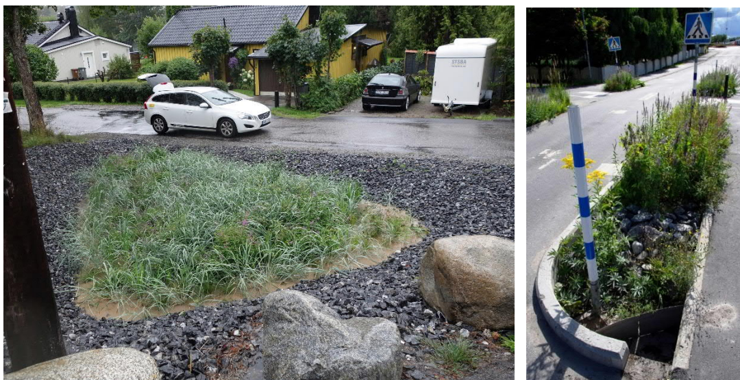
Figur 15. Exempel på nedsänkta växtbäddar. Bildkällor: VegTech AB samt Dagvattenguiden.se
