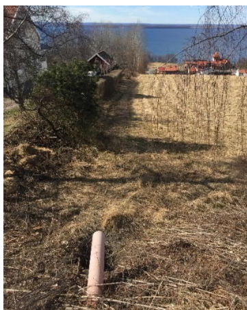
Figur 6. Vägavvattning från Jönköpingsvägen som släpps till nu obebyggd fastighet 8:4 (t.h.). Till vänster fastighet 8:7.
