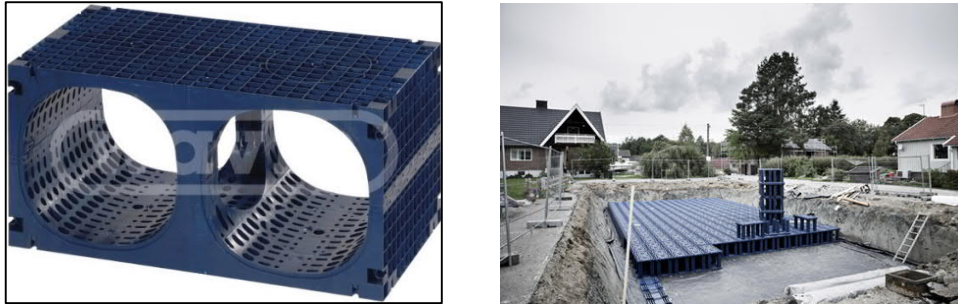
Figur 16. Körbar dagvattenkassett samt anläggande av kassettsystem. Bildkälla: Wavin.se
