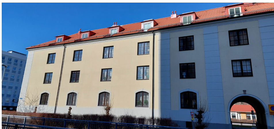
Figur 5 Del av fasaden på befintlig bebyggelse inom planområdet. Foto taget från Pilgatan.
