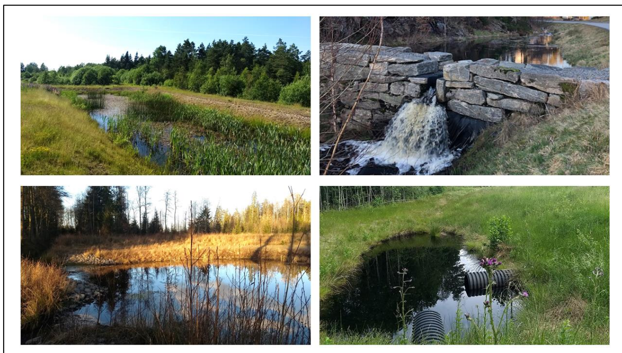
Figur 11. Exempel på dagvattendammar.
