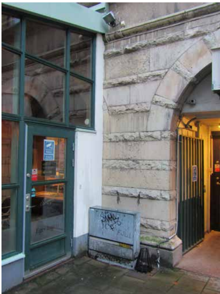
Serveringstillbyggnadens anslutning mot naturstensfasaden.
