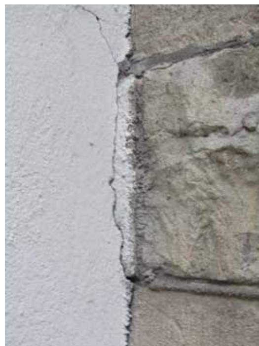
Tillbyggnadens putsfasad stöter mot naturstensfasaden och detta kommer att kräva borttagning av rester av puts och färg vid en rivning.
