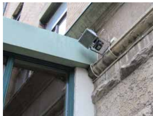
Tillbyggnadens anslutning upptill.
