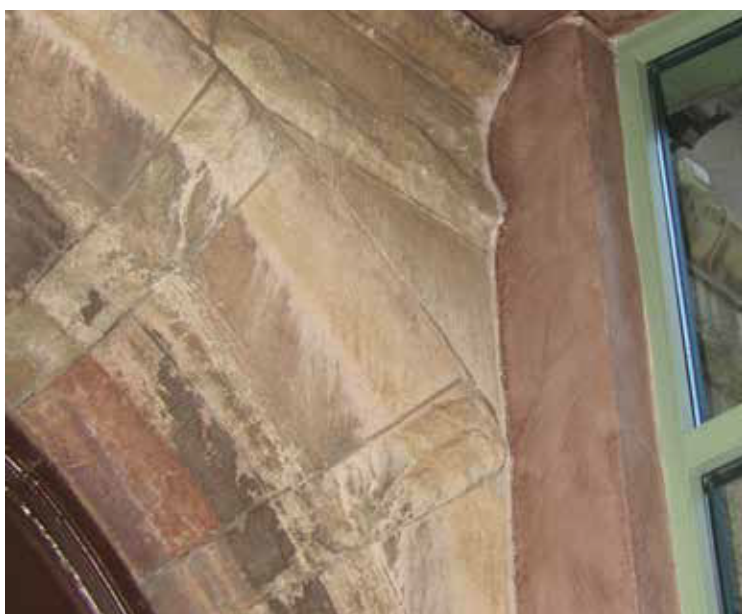
Även invändigt stöter de invändiga material- och målningskikten mot naturstenen, vilket kommer att kräva rengöring.
