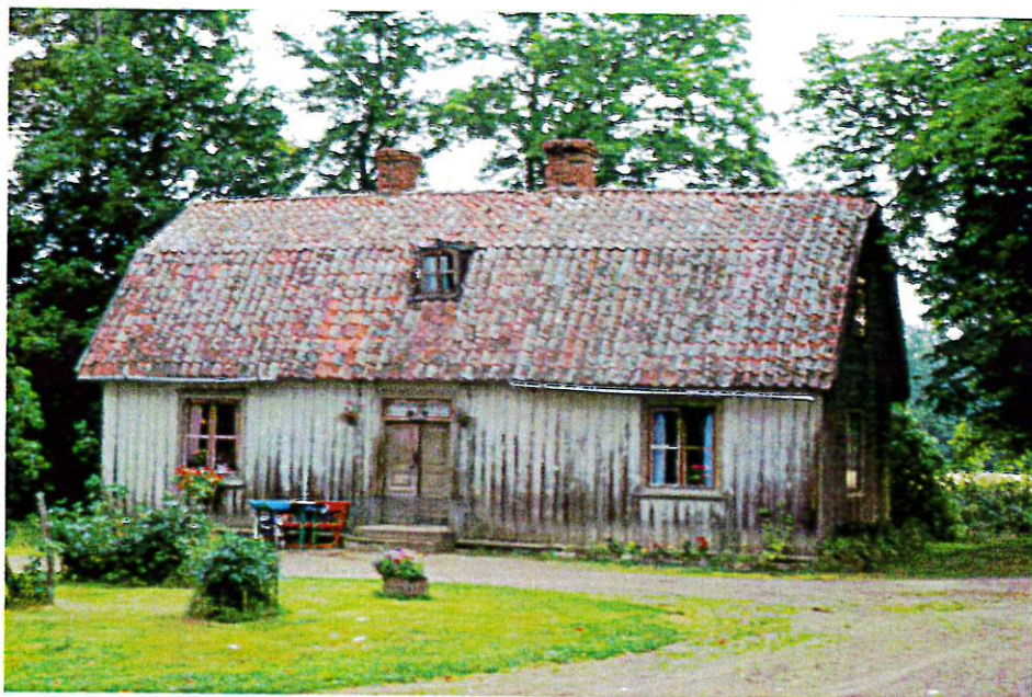
Figur 11. Östra flygeln före renoveringen på 1970-talet. Foto Bo E Karlsson. Jönköpings läns museum.
