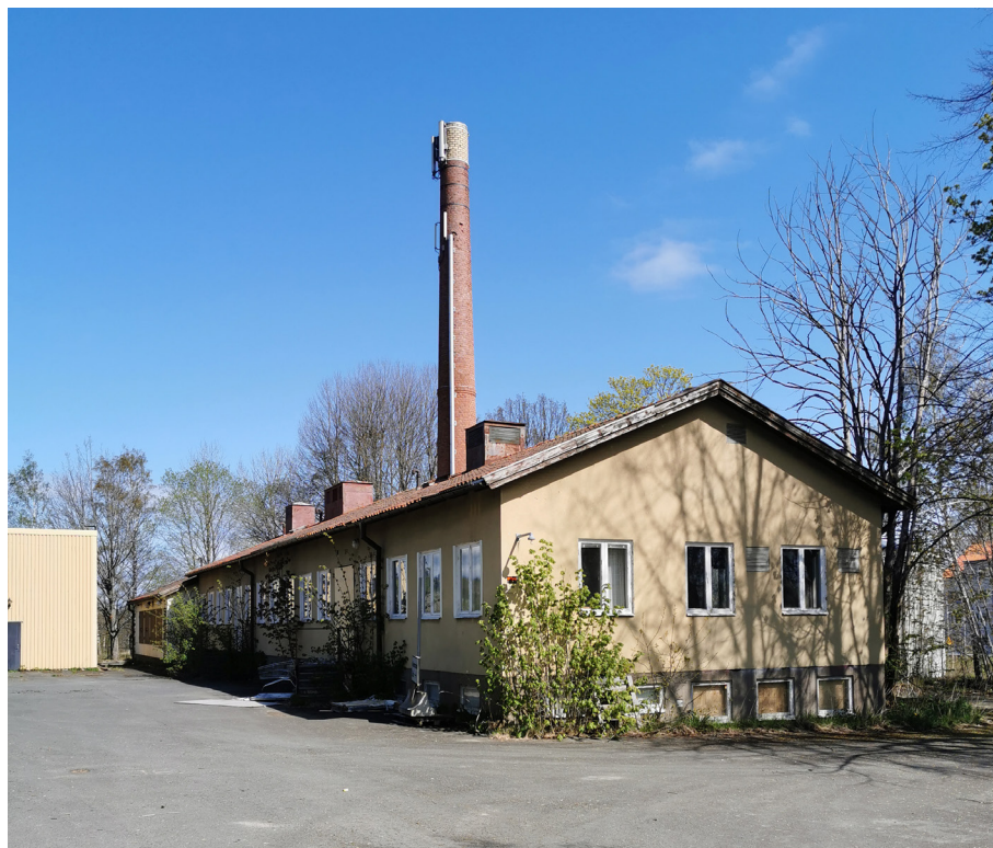
Figur 17. Foto på den f.d. panncentral.
