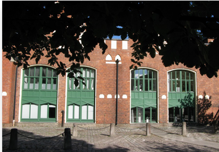
Spårvagnshallarna, Centrum Väster i Jönköping, juni 2017
