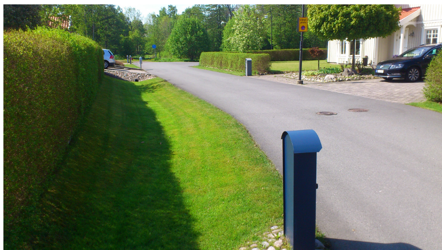
Exempelbild på gata med grönt dike på en sida, med rör under garageöverfart som leder dagvattnet vidare
