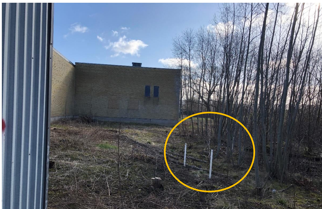
Figur 3. Tre äldre rör söder om Idrottens hus.
