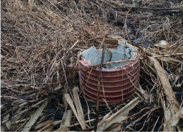
Figur 4. Rör som kanske utgör kontrollbrunn för mätning av deponigas i det gasdränerande diket.
