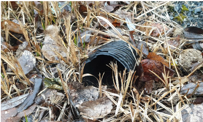
Figur 3. Rör som kanske utgör markventilationsöppning för gasdränering under Stenhuggargatan. Inget utsläpp av metan vid mättillfället.
