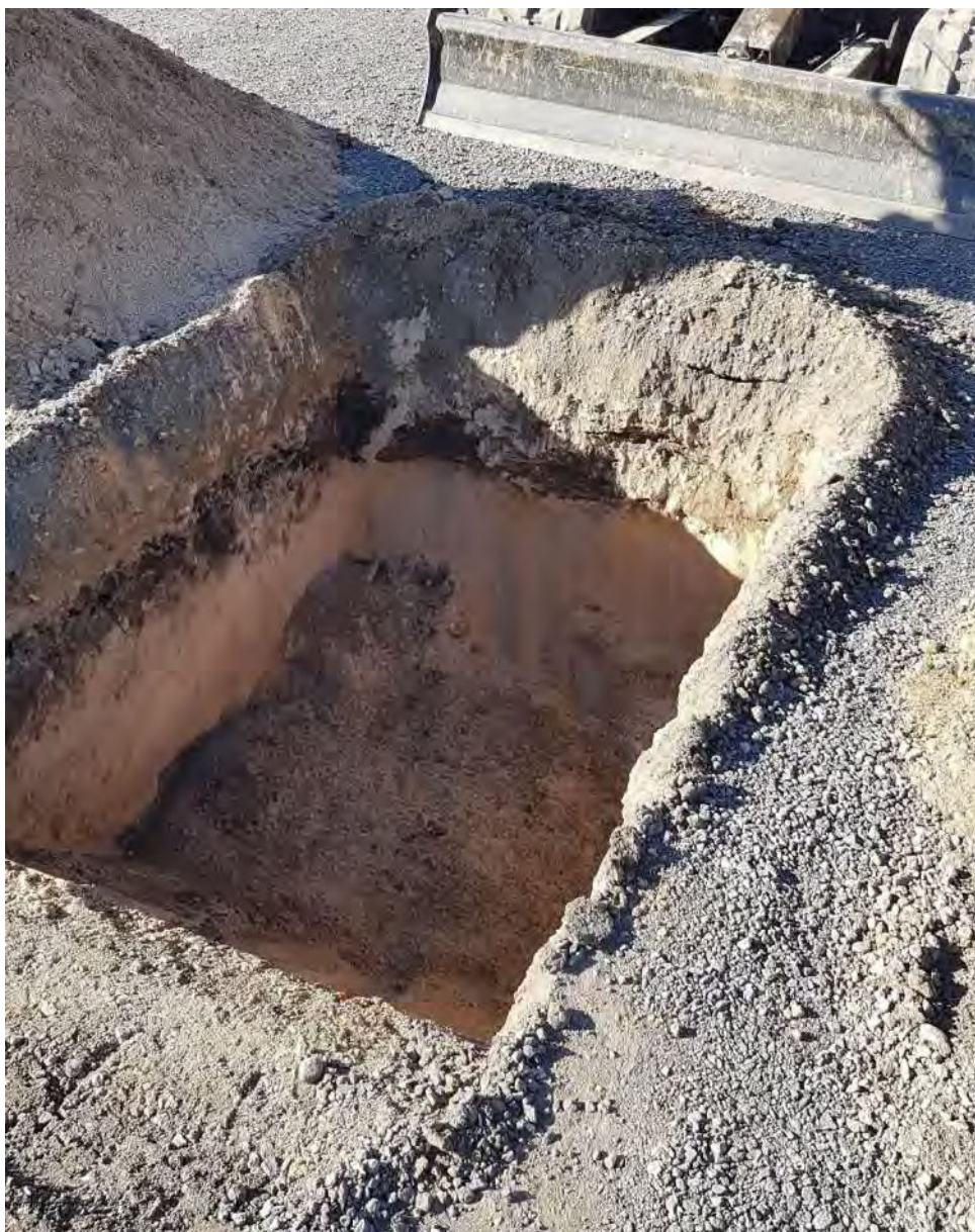
Figur 5. Provgrop SW1810 vid bef. parkeringsplats. Djup 1 m. Översta halvmetern består av bärlager och ett svart lager fyll med spår av tegel följt av underliggande ljus sand.
