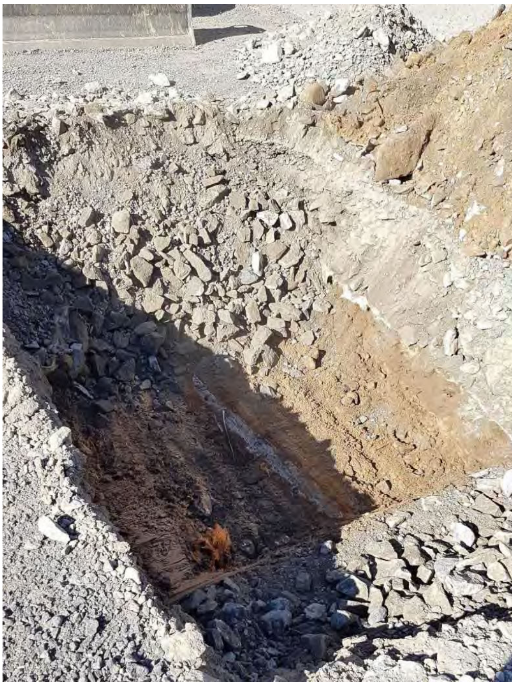
Figur 4. Provgrop SW1809 vid bef. parkeringsplats. Djup ca 1 m. Stopp pga. stor rostig ledning. Även spår av blött trävirke. Ovanliggande bärlager av kross ner till 0,4 m.
