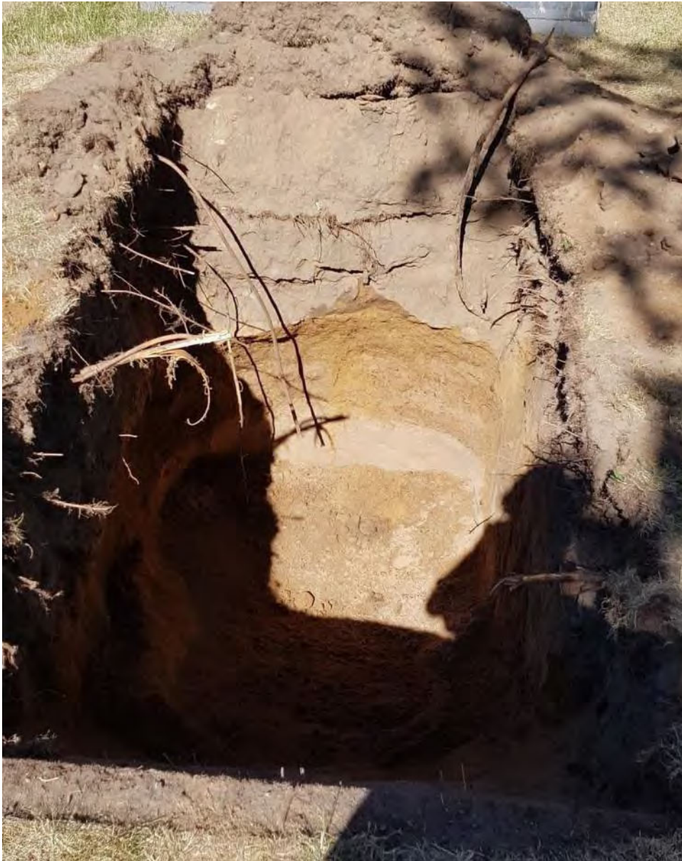
Figur 2. Provgrop SW1806. Djup 2 meter i sand/jord. Översta metern utgörs av fyll med jord, glas, tegel, kabel.
