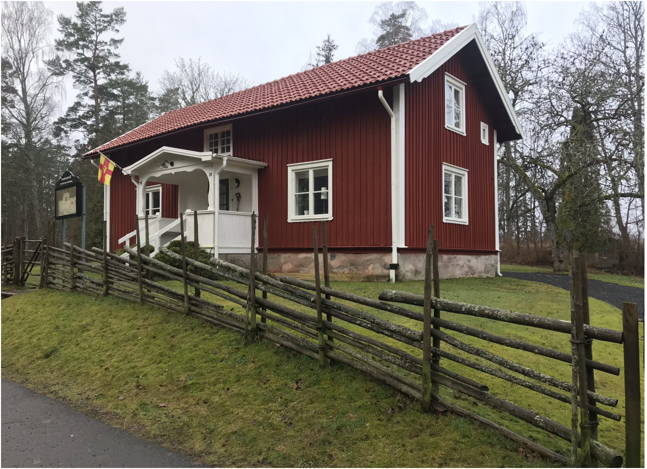
Befintlig byggnad på Flahult 2:343
