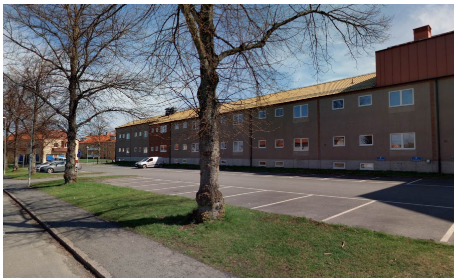
Skolbyggnad, parkering samt trädrad sett från Källgatan.
