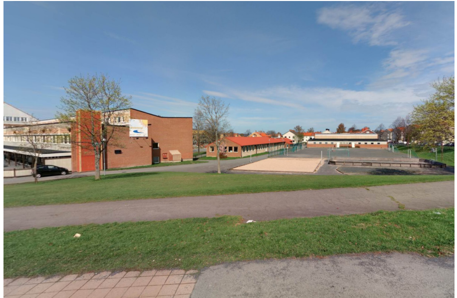
Skolbyggnad och friyta för bollspel sett från Hermansvägen.
