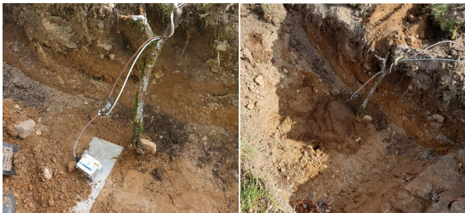
Figur 4 Givaren i MP 1:1 monterad och placerad i våg i schaktgropen till vänster och övertäckt av jord till höger.
