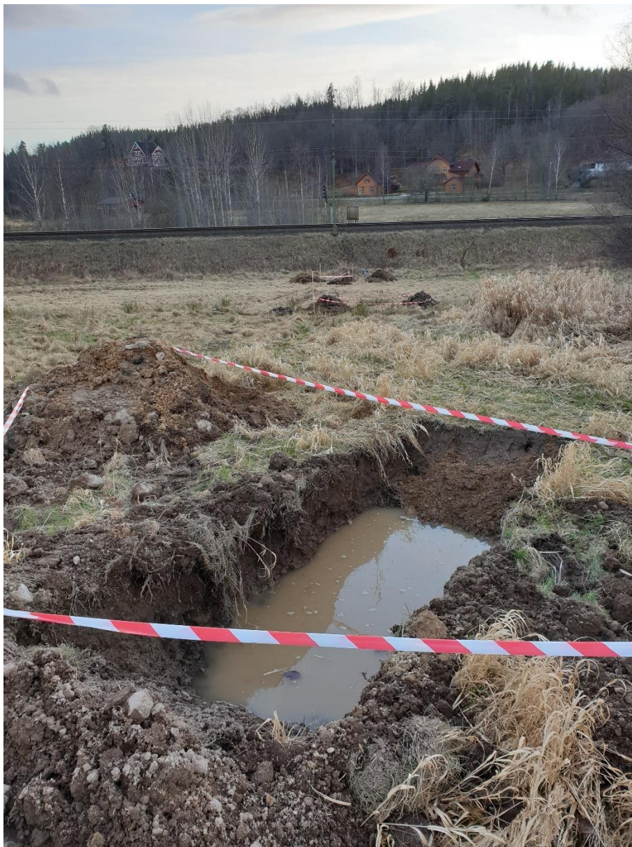
Figur 10 Givaren i MP 2:3 redan övertäckt med jord i den borte delen av schaktgropen från fotopositionen sett.
