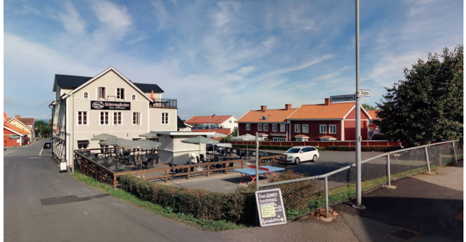
Fastigheten Göken 4 med vy från Hamnvägen i nordvästlig riktning.
