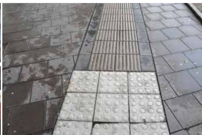
Den räfflade ytan på ett taktilt ledstråk bör göras 0,60–0,70 m bred och ska omges av slät yta. Höjden på strukturen ska vara minst 4,5 mm.
