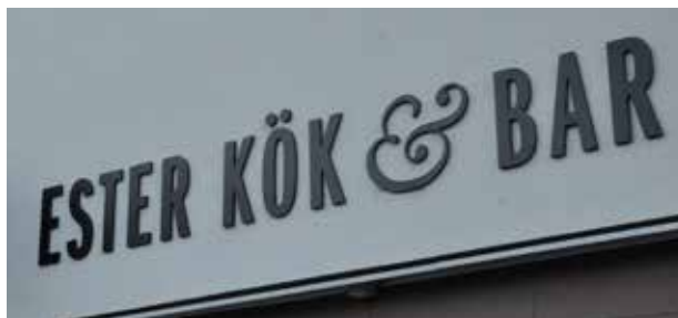
Friliggande bokstäver på fasad
