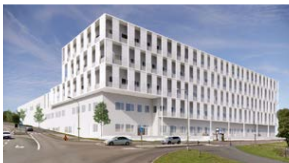
Byggnadens södra delar är lägre än dess norra - vilket skapar en finare höjdmässig övergång till befintlig skolbyggnad.
