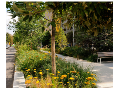
Rengbädd nedsänkt för att leda in dagvatten
