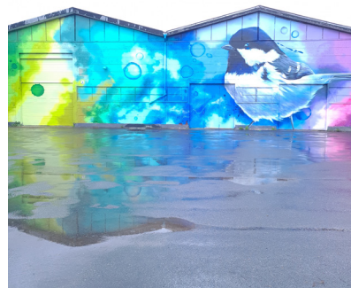
Befintliga byggnader i området
