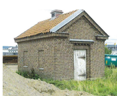
Befintlig byggnad, Pudretten
