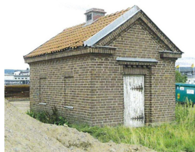
Befintlig byggnad, Pudretten
