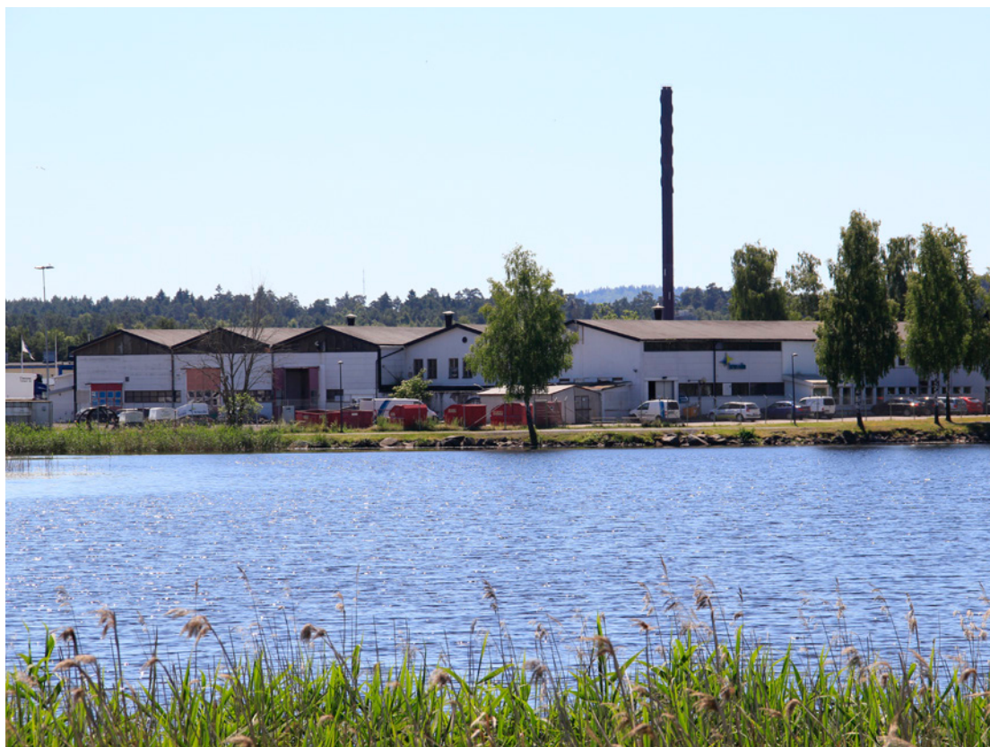
Östra delarna av utredningsområdet, sett från Simsholmen. 1950-talsindustrierna vid Syrgasvägen bildar här en front mot Munksjön och strandpromenaden.
