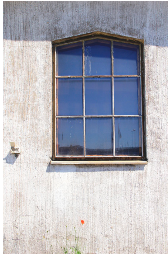
Flera industribyggnader har ursprungliga fönster, här småspröjsat gjutjärn på f.d. svets- och smidesverkstad i kvarteret Övergången 5, 1950-tal.
