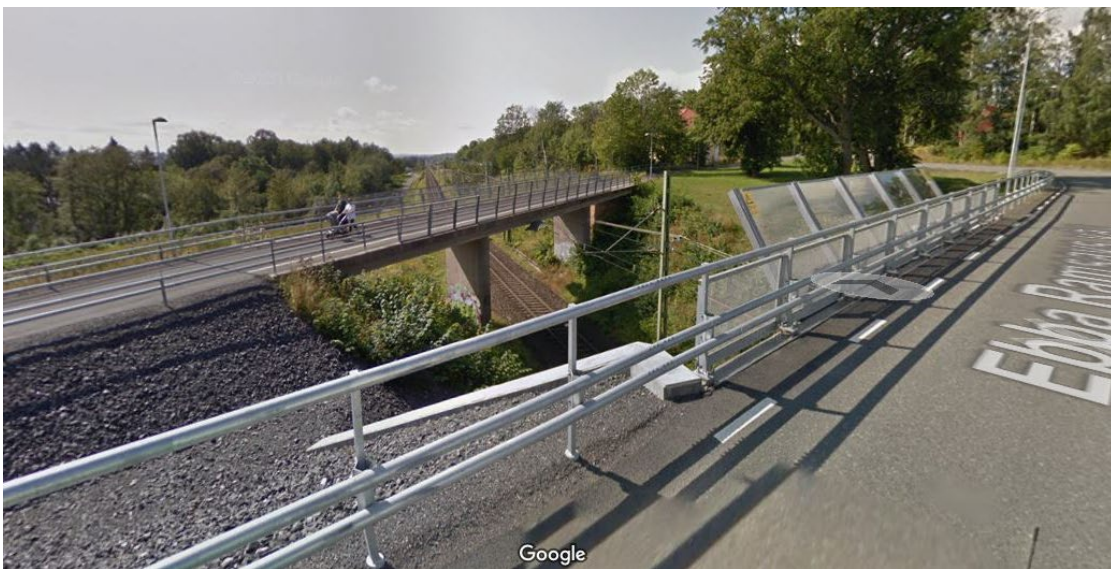
Från NO vid broarna över Jönköpingsbanan
