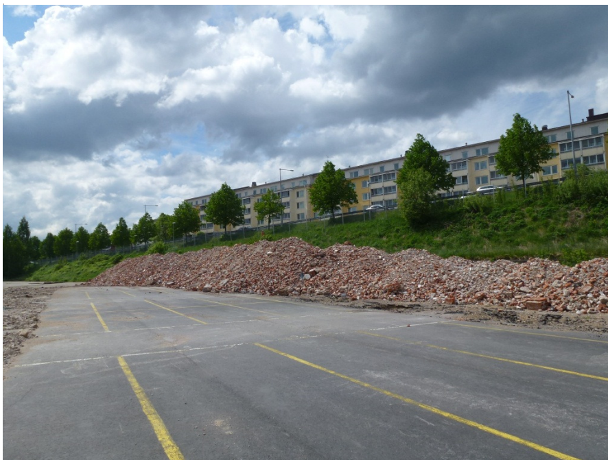
Foto 2 (2013-05-29) Upplag av rivningsmaterial nedanför slänten mot Barnarpsgatan, högen är upp till ca 4-5m hög.
