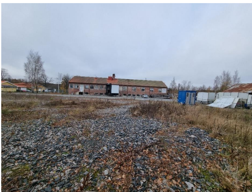
Figur 3. Bild vid riven byggnad mot en av de befintliga byggnaderna. Foto av Tyréns Sverige AB.
