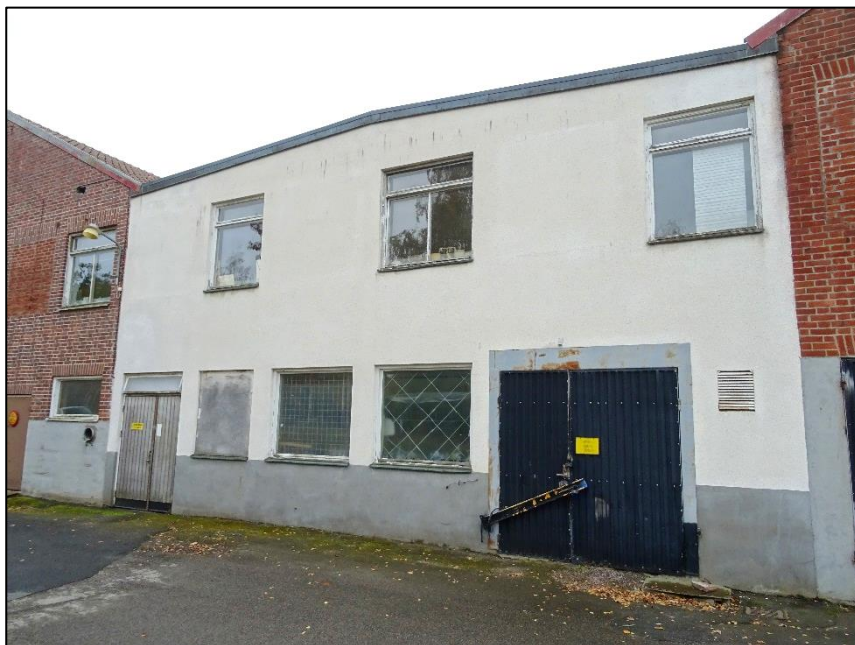
Byggnad D:s fasad mot norr
