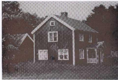
KLÄMMESTORP 1:6, JÄRSTORPS SOCKEN
