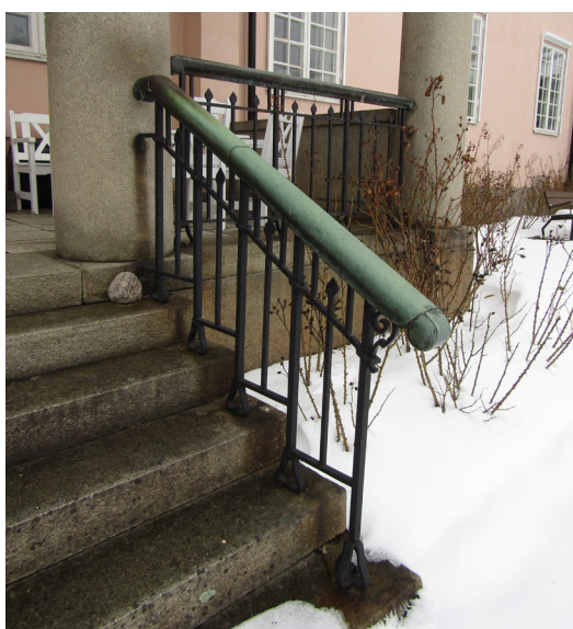
Äldre byggnadsdetaljer på huvudbyggnaden.
