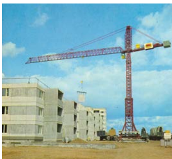
Bebyggelsen byggdes med hjälp av spårbundna lyftkranar.
