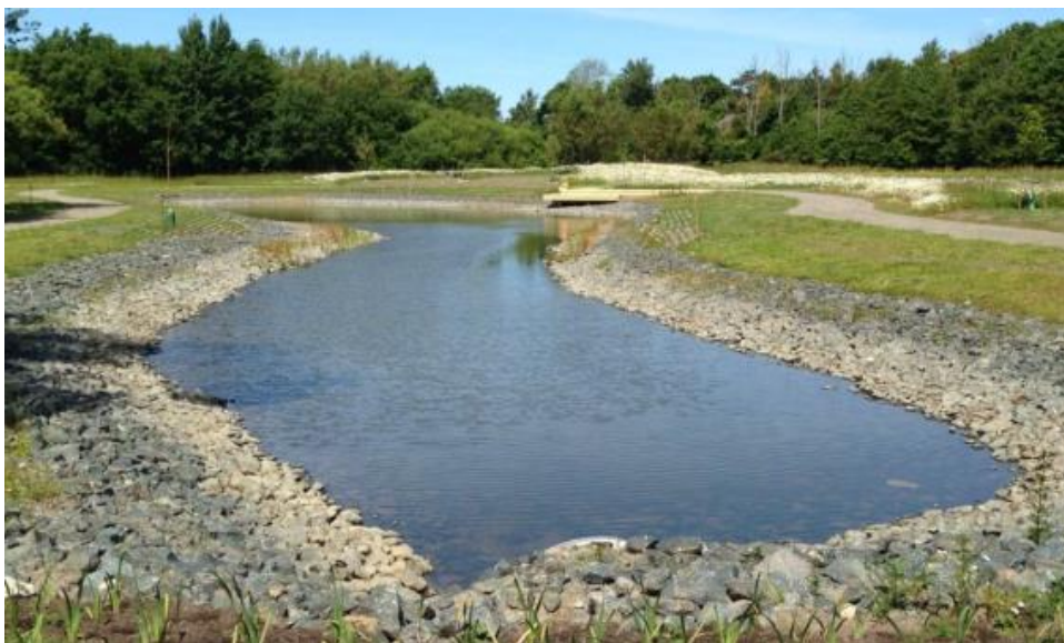
Figur 23. Exempel på dagvattendamm i Trönninge i Varberg. Foto: Norconsult.
