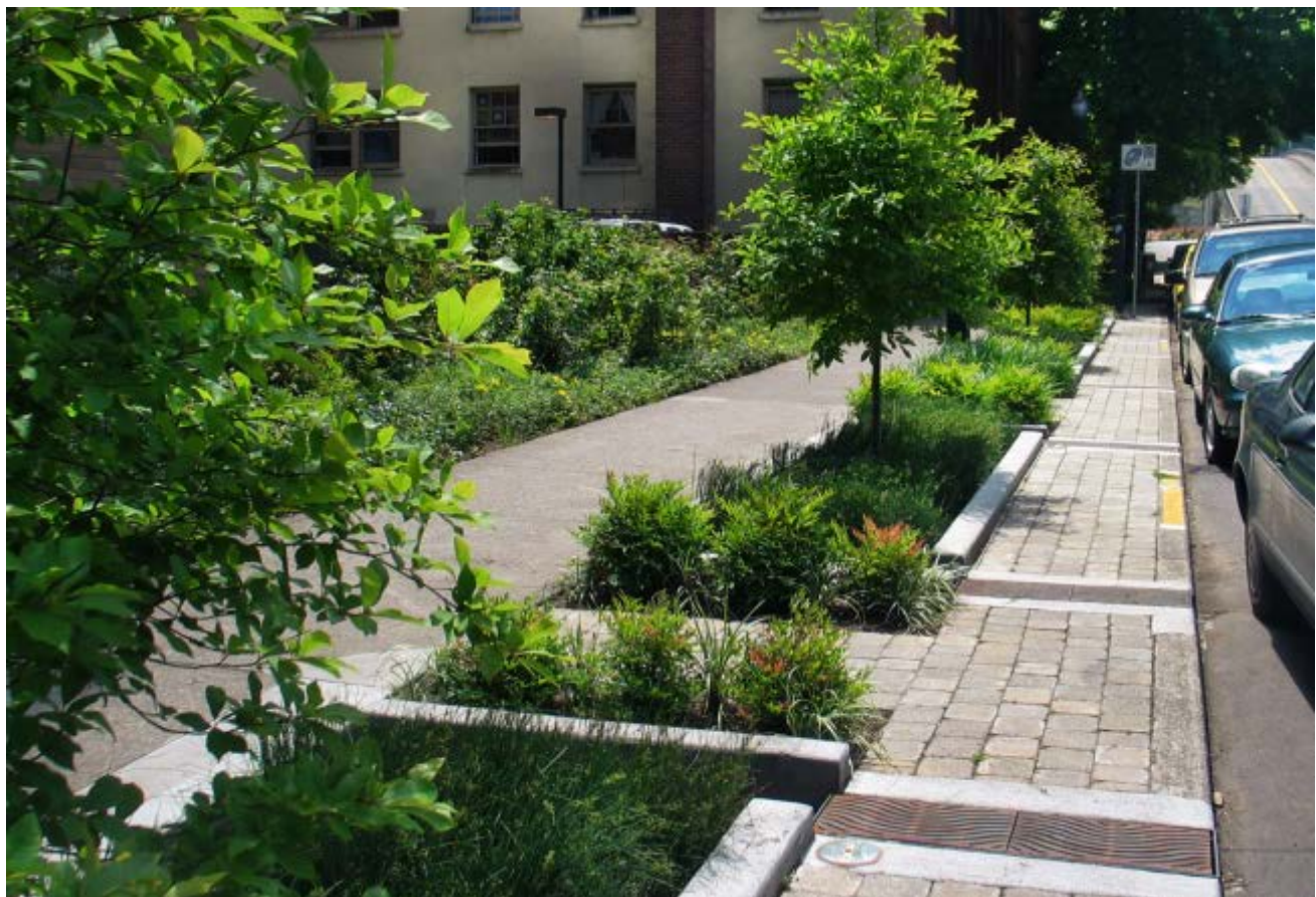
Exempel på regnbädd som del i ett infiltrationsstråk i verklig gatumiljö
