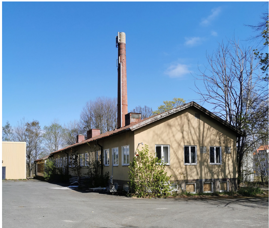
Figur 17. Foto på den f.d. panncentral.
