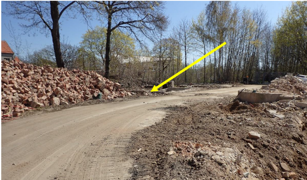
BILD 2 PROVTAGNINGSPLOTS, SCHAKTBOTTEN FRÅN FD PUMPHUS/ OLJEFÖRRÅD, GUL PIL
