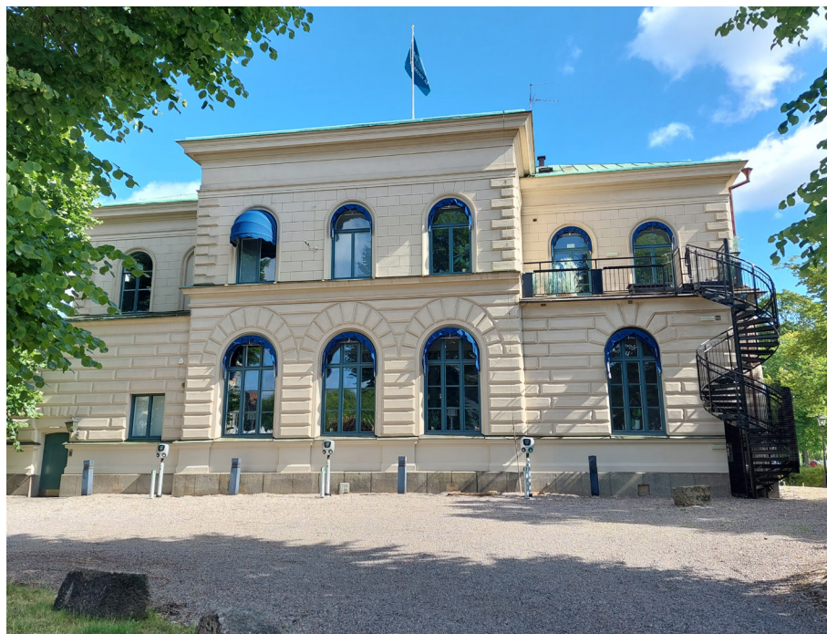
Huvudbyggnadens baksida. Foto taget från söder.
