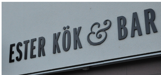
Friliggande bokstäver på fasad
