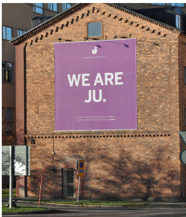
Stora fasadvepor är bygglovspliktiga.
