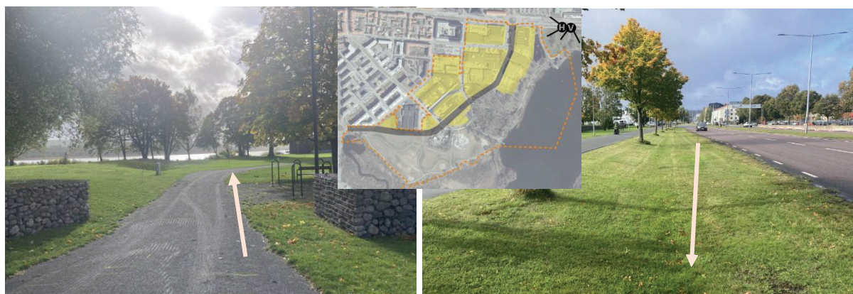
Figur 5: Vänster bild visar en av fler ingångar mot Knektaparken. Parken omges av en mur av sten mot Odengatan. Höger bild visar grönområde parallellt med Odengatan norr om Knektaparken.
