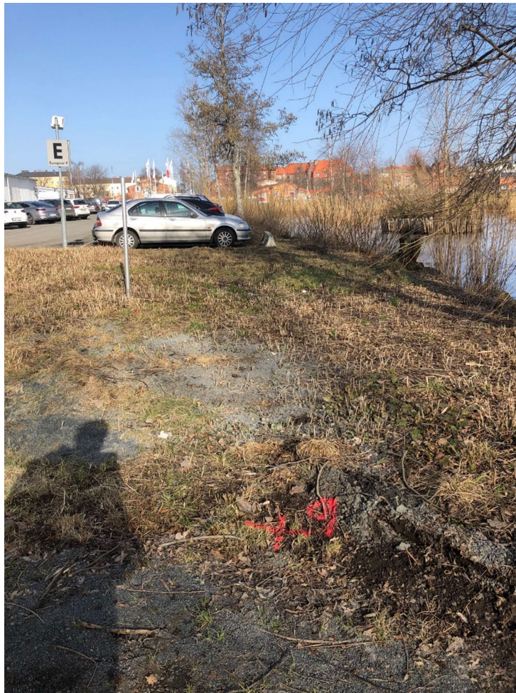
Figur 2. Slänt mot damm vid punkt 19M009.
