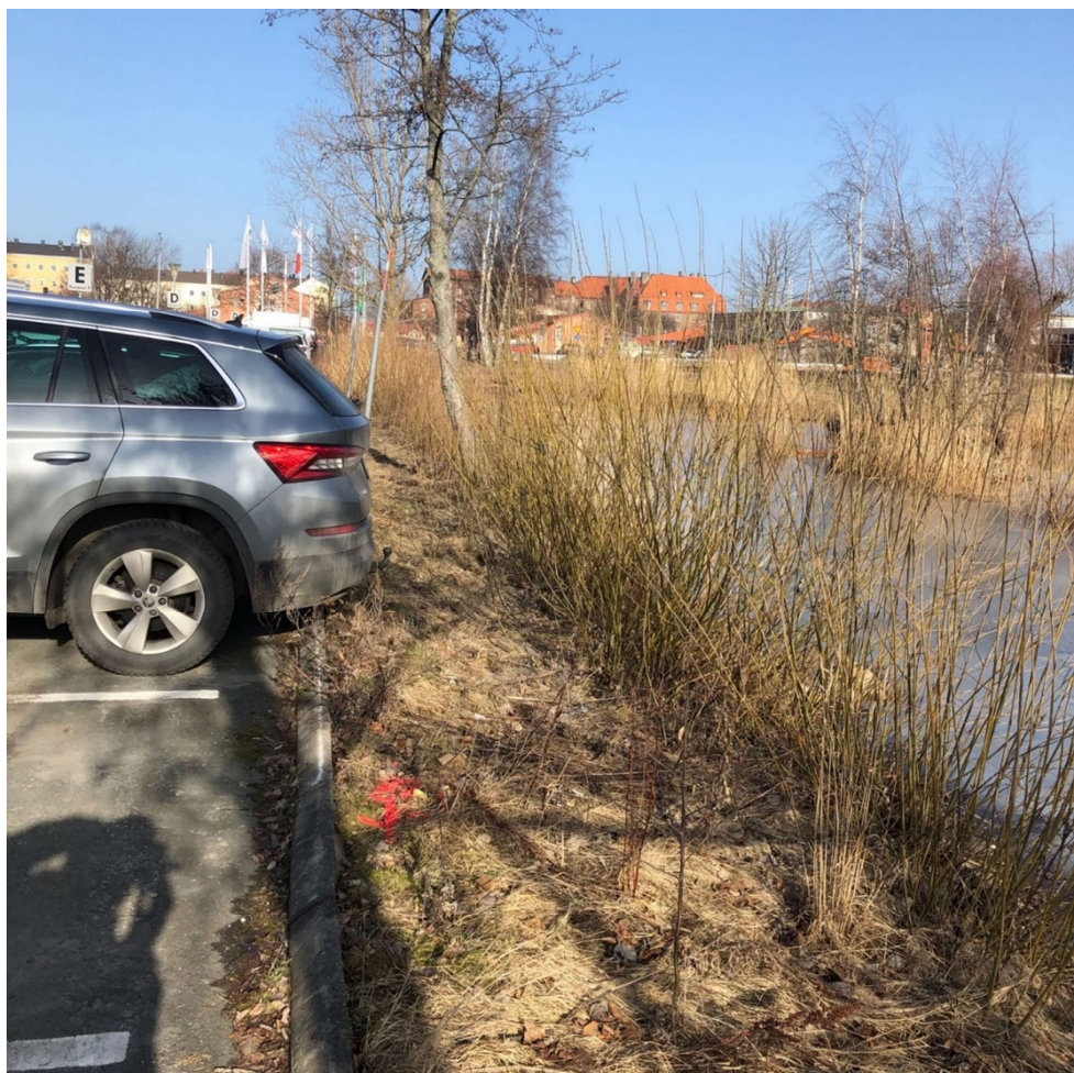
Figur 1. Slänt mot damm vid punkt 19M005.
