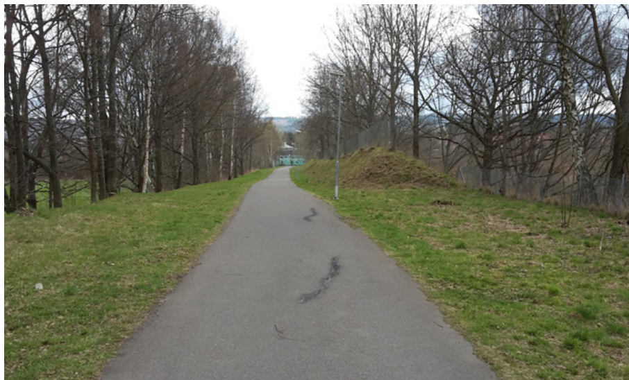
Befintlig gång- och cykelbana som idag löper igenom planområdet.
