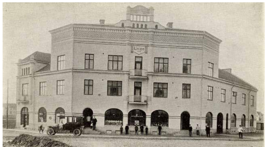
Figur 18. Det historiska fotot visar den ursprungliga byggnaden på platsen med gaveln ut mot nuvarande Erik Dahlbergs Plan.
