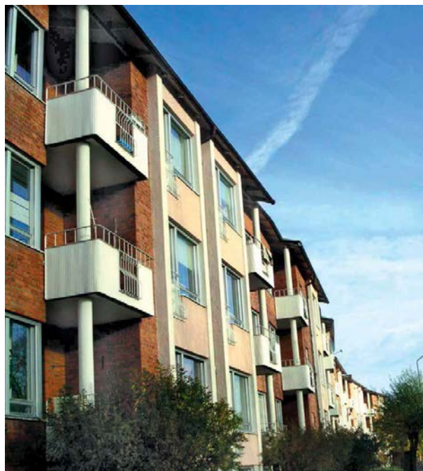
Kv. Vidöstern Burspråkspartier, franska balkonger och ursprungliga balkongpartier. Bebyggelsehistorisk inventering Österängen.
