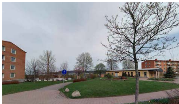
Fotografi: Befintlig byggnad, grönt släpp och gång- och cykelväg vid område F, samt angränsande lamellhus bebyggelse.
