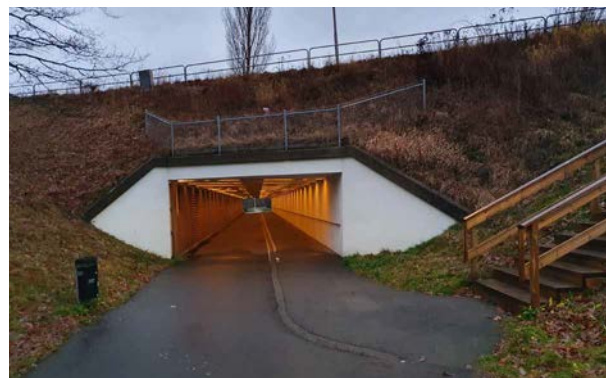
Fotografi: Gång- och cykeltunnel mot Vättersnäs.
