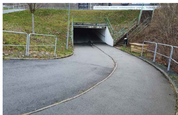
Fotografi: Gång- och cykeltunnel mot Kungsängen.
