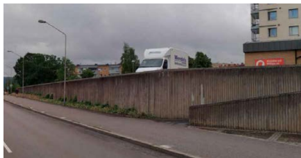
Stödmur mot Birkagatan där omvandling och nya byggrätter föreslås.
