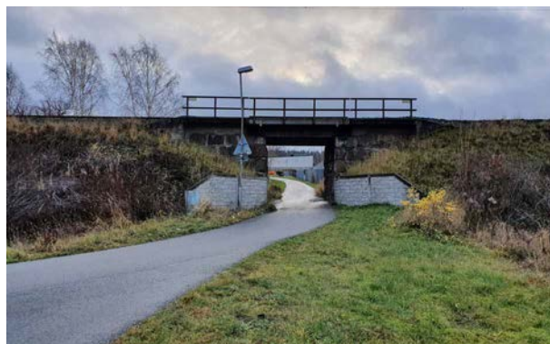
Fotografi: Gång- och cykeltunnel mot Ekshagen.
