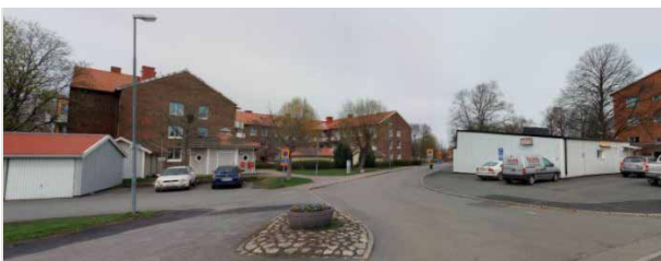
Fotografi: Infart till Duvgatan, verksamhetslokal och garage
