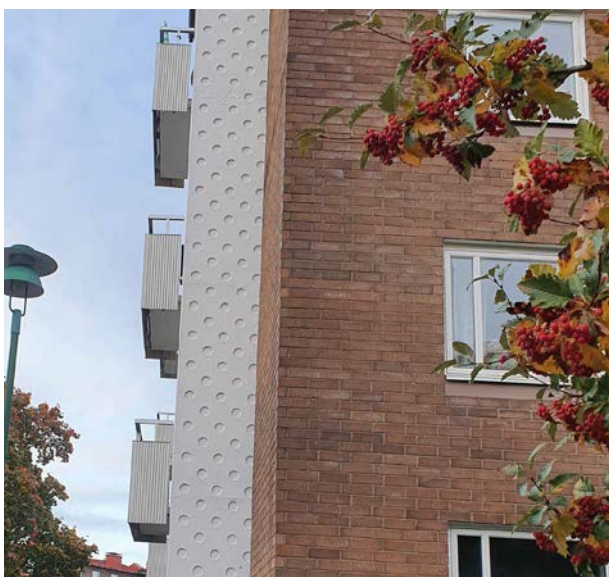
Kv. Västerås - välbevarat vertikalt genomgående balkongparti i material som: formgjuten betong, järnsmide och korrugerad plåt.
