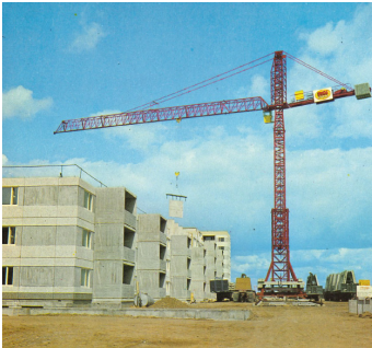
Bebyggelsen byggdes med hjälp av spårbundna lyftkranar.
