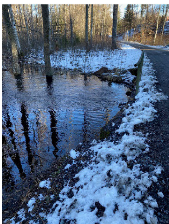
Bilder taget på bron vid Ringstigen/Dunkehallaån 26 februari 2022
