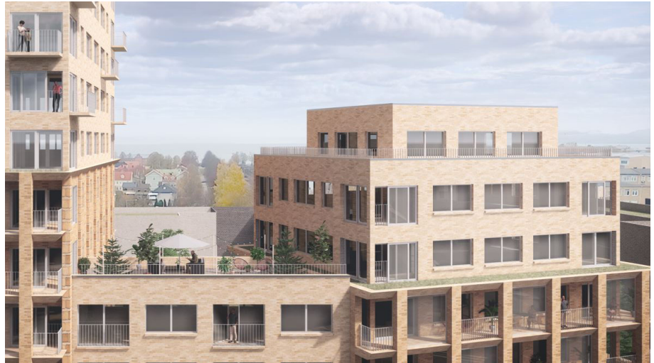
Figur 22. Bilden visar utsikt från våning 5 för byggnaden på fastigheten Peru 6.
