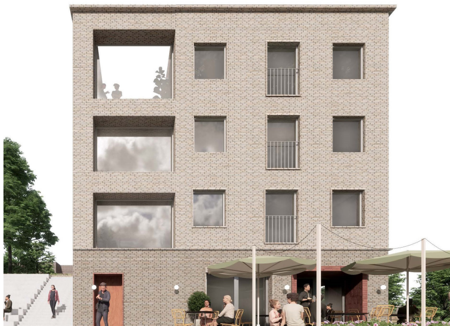
Figur 13. Bilden visar ett bullerskydd som är integrerat i fasaden.
