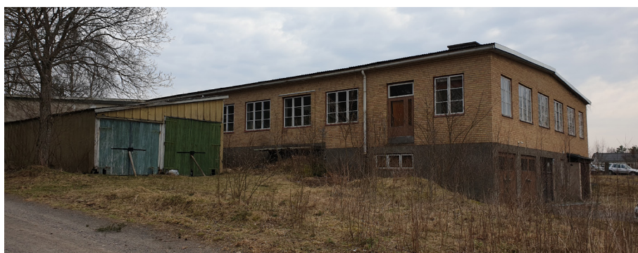
Befintlig industribyggnad på Bottnaryd Prästgård 1:52.
