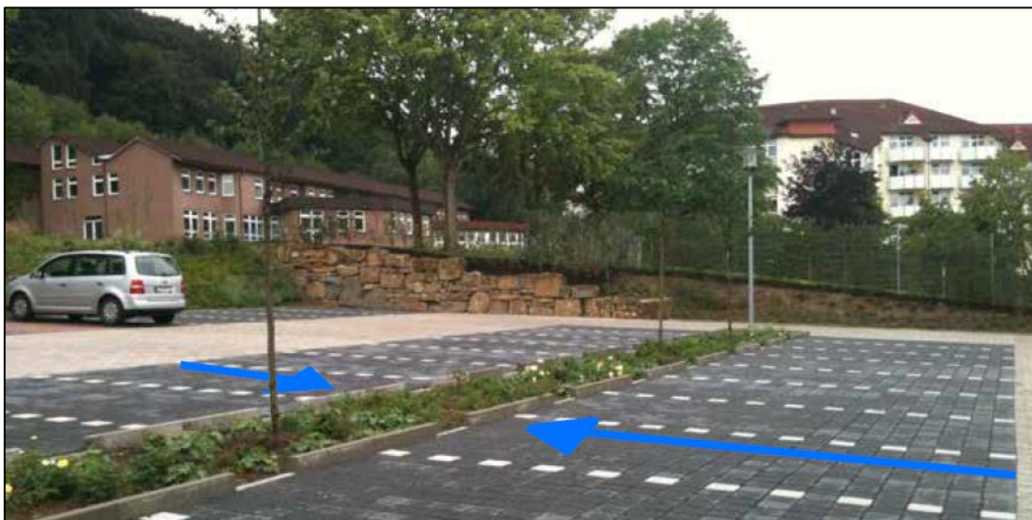
Figur 5-2. Exempelbild på infiltrationsstråk inom en parkeringsyta, från Uppsala Vattens exempelsamling för dagvattenhantering.
