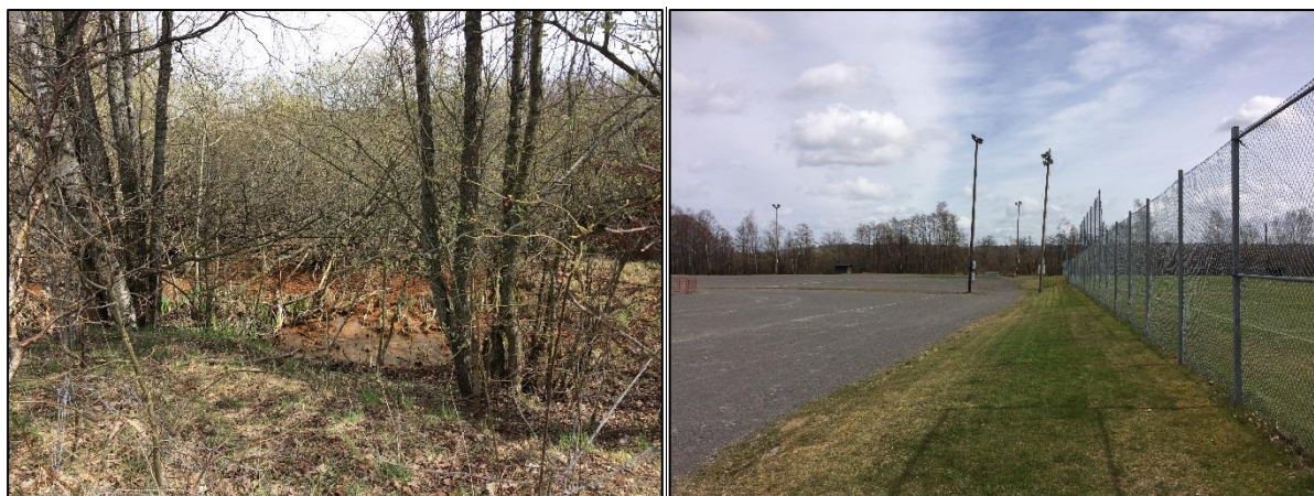
Figur 2-1. a) Våtmark mellan planområdet och Tabergsåån. b) Sättningar är synliga i mitten av planområdet.
