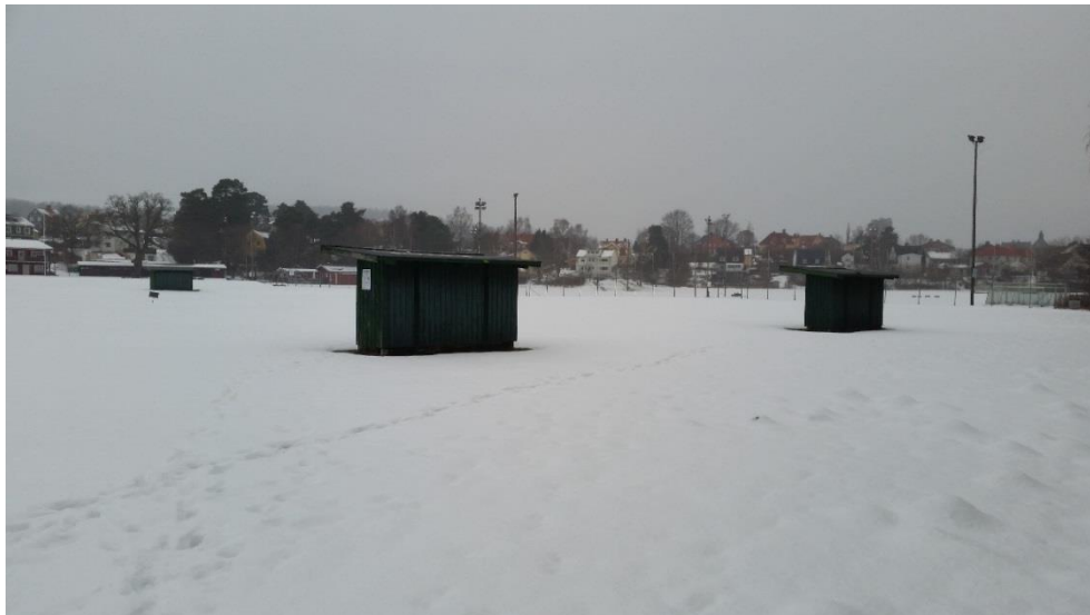
Figur 3. Översiktligt foto över de anläggningar som återfinns på det norra delområdet. (källa: Platsbesök Sigma Civil AB)
