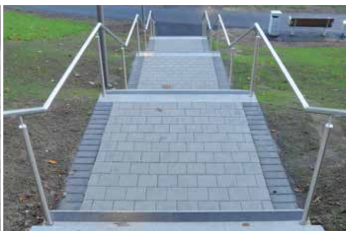
Trappa med kontrastmarkering i trappans början och slut.
