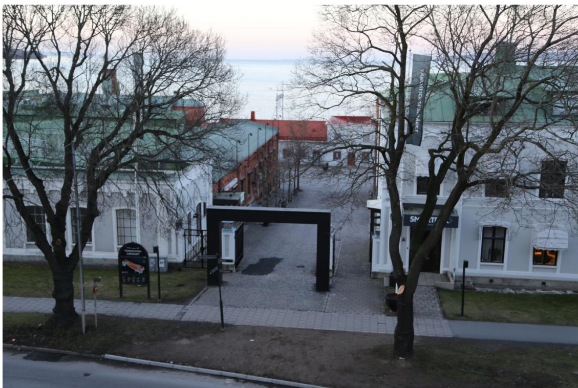
Området sluttar svagt ner mot Vättern. Fasaderna är i huvudsak i rött tegel och i mindre utsträckning ljus puts. Den äldsta fabriksbyggnaden i foden på bilden är uppförd i trä.
