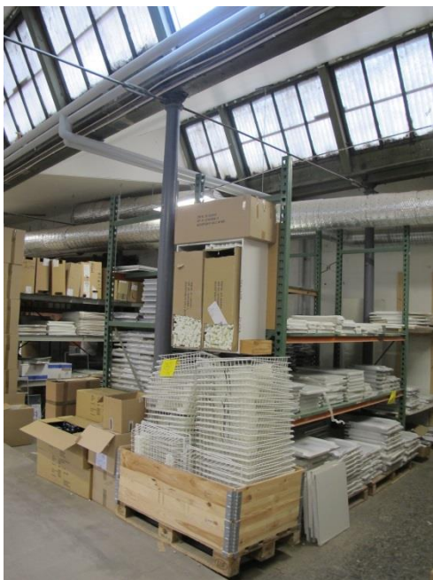
Ursprungligt tak och synlig byggnadsstomme i byggnad D
