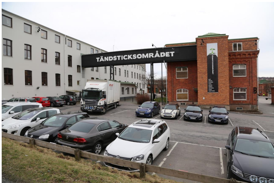
Den täckta övergången mellan hus A och hus B är en av få lämningar som speglar den industriella produktionens transportbehov.
