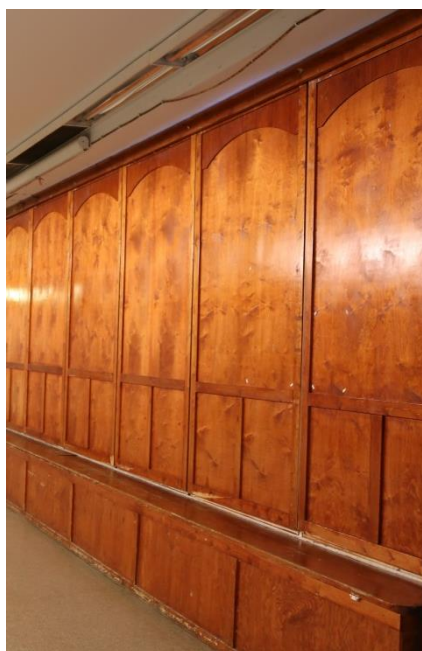
Fanérbeklädd vägg i byggnad E
