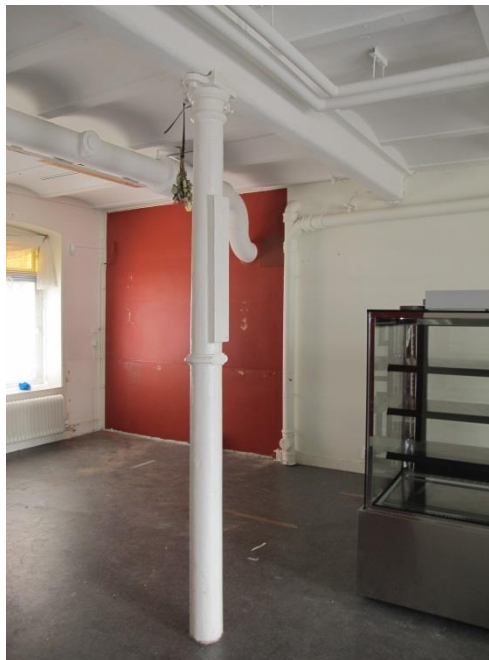
Synlig byggnadsstomme i byggnad C
