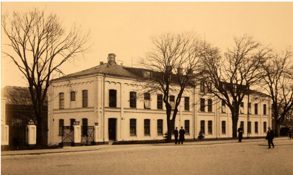
Huvudentrén med kontorsbyggnaden, här ser man den gamla grinden samt parkstråket längs Västra Storgatan. Äldre fotografi.
