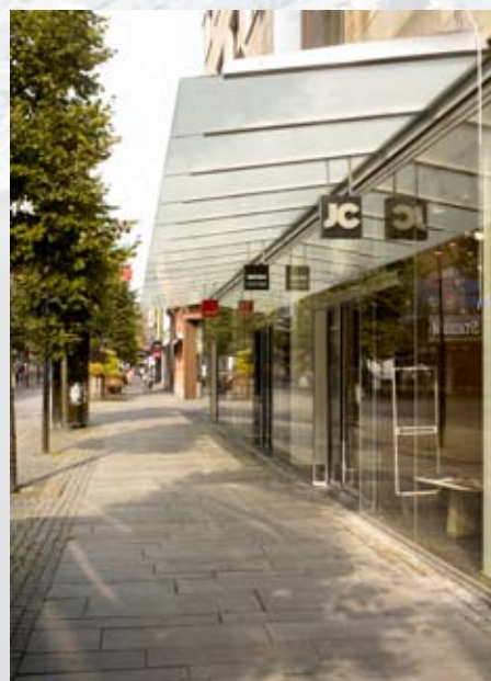
Exempel på befintligt skärmtak som har en lätt och luftig utformning
