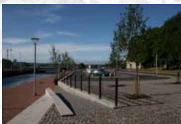
Omflyttning av bussar & ny parkeringsplats, 2008
