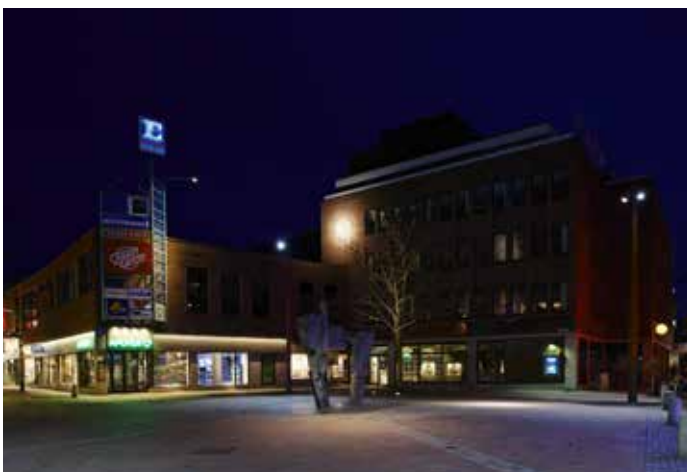
Visualisering visar grundbelysningen som är installerad på Hovrättstorget.
