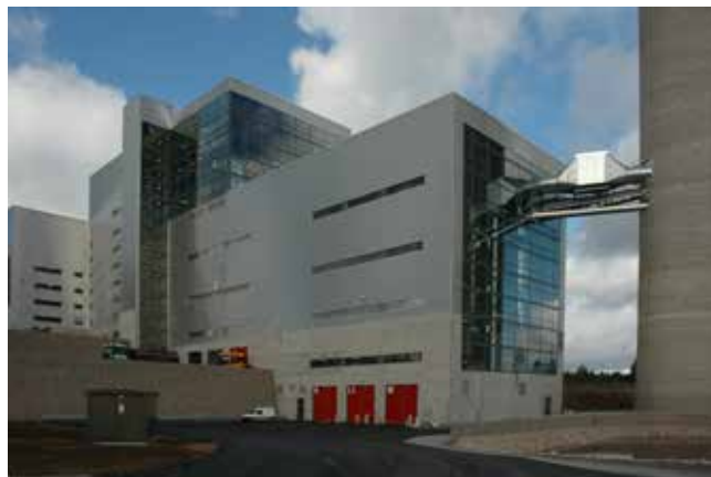
I kraftvärmeverket på Torsvik bränns hushållsavfallet och blir till fjärrvärme och el.
