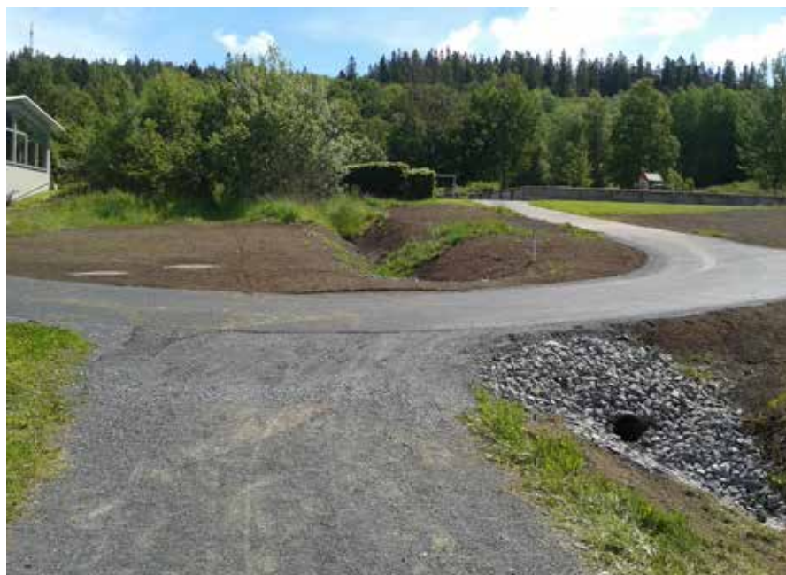
I planprogrammet för Ekshagen, Jära har den gamla vägen fått en ny funktion i bostadsområdet. De ger mervärde i bevarande av kulturhistoria och värden för fotgängares framkomlighet. På bilden syns ett öppet dagvattendike parallellt med den gamla färdleden som går in i naturen över en nysådd gräsytta.
